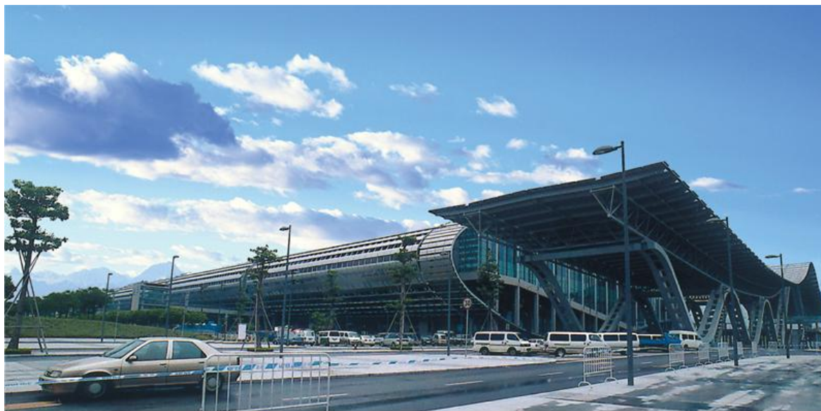
110kV电缆在琶洲会展中心成功运行
