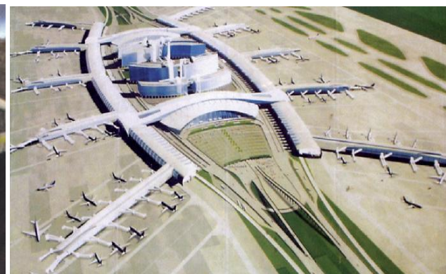
110kV电缆在新白云机场成功运行
